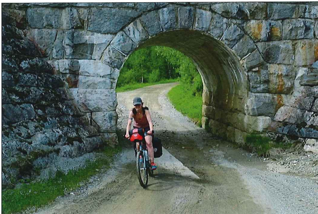
Jernbaneundergang. Foto: Carl Norberg (2016)
