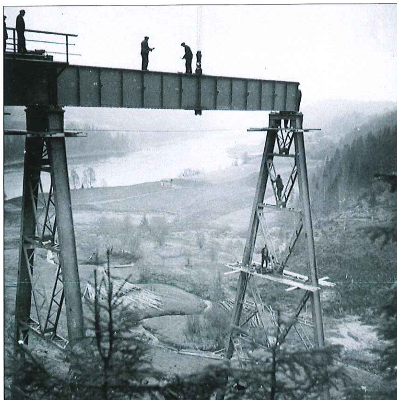
Trolldalen viadukt. Foto: Norsk jernbanemuseum (1938)
