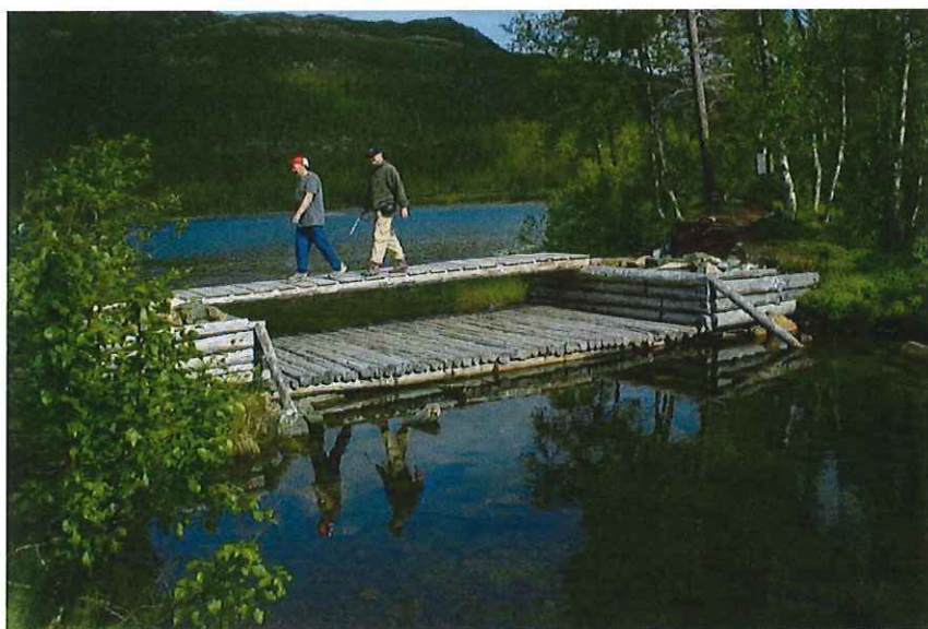
Fløterdam Stavatnet. Foto: Are Halse
