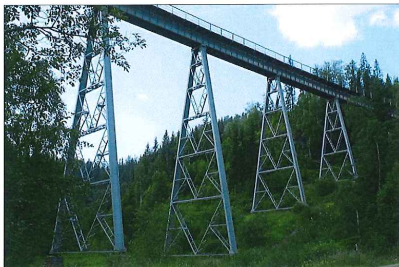
Trolldalen Viadukt. Foto: Are Halse (2018)
