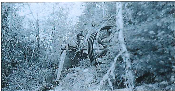
Rester av drivhjul for vandrevet sag Foto: Ukjent
