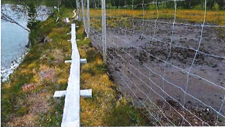
Stien på nordre side ble lagt utenfor reingjerdet i 2017 og klopplagt
