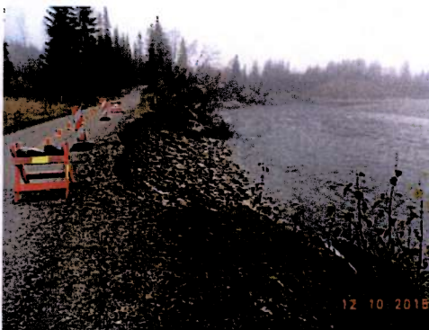
Erosjonsutsatt parsell sett medstrøms Oppstrøms ende av sikringstiltaket blir mot fulvert fra Øvergårdselva.
